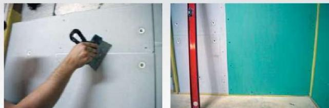
При монтаже гипсокартонных листов используются саморезы 3,9x41 мм. Саморезы не должны попадать на виброузлы сэндвич-панелей. Шаг саморезов по вертикали составляет 200 мм, по горизонтали – 400 мм.
